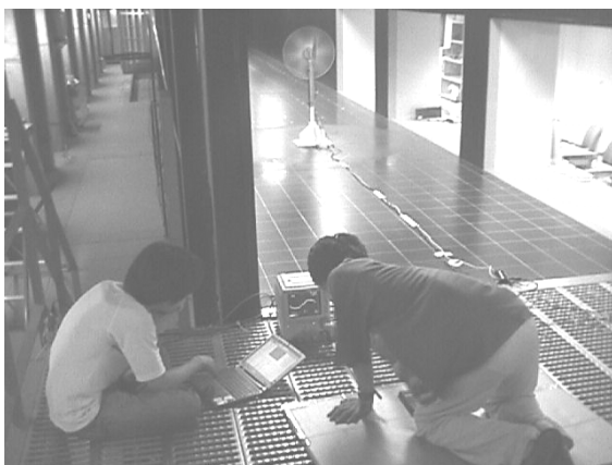
(c)出力電圧波形・負荷電力の測定
