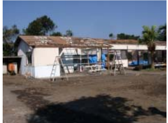
写真24 全壊した宿泊施設
