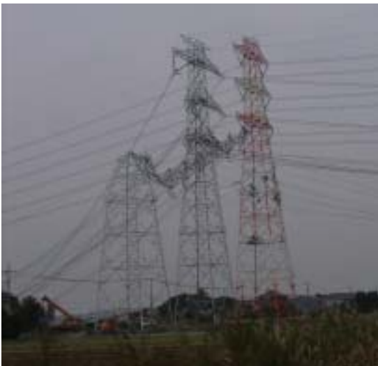
写真 10 湖南線 22 号鉄塔
