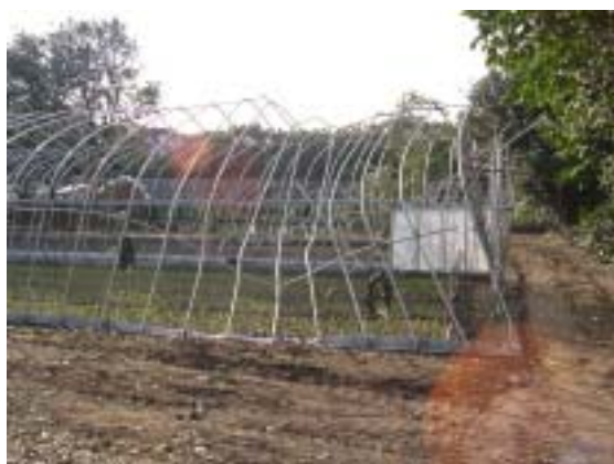
写真 31 倒壊した樹木(樁)によるビニルハウスの被害
