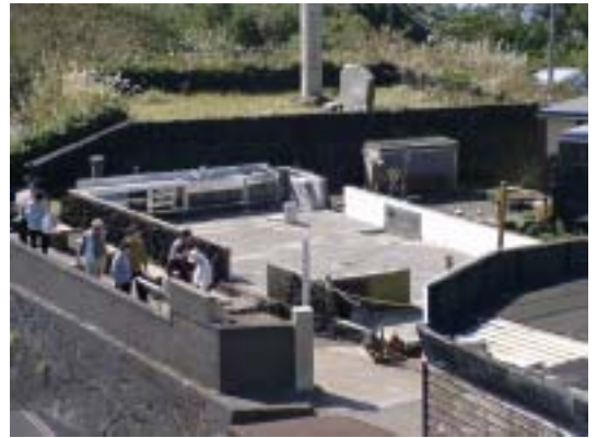
写真 21 上屋が吹き飛ばされた御神火茶屋
