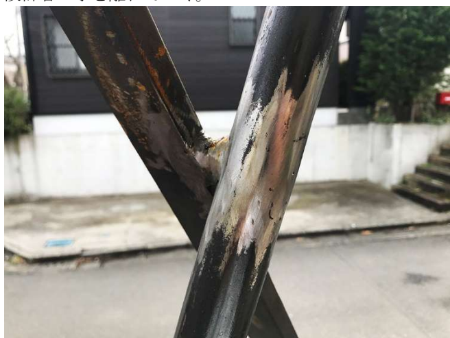
図 26. 防錆処理の有無によって異なる経年変化をするふたつの鋼材
