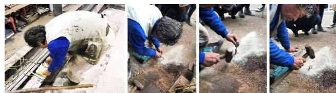
図 20. ケミカルアンカーの試験打設の様子
