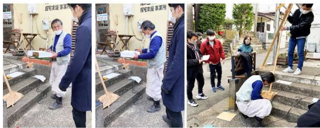
図 11. 現場での模型確認（左）とコンクリートの厚さの確認（右）
