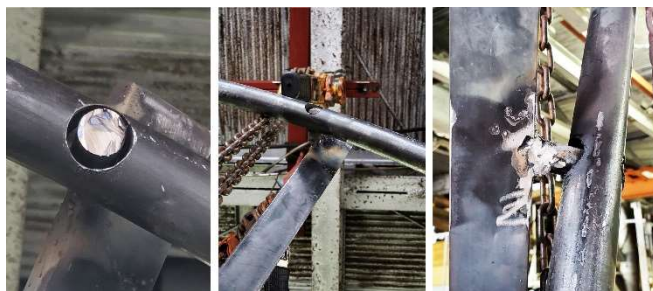
図 15. 全周溶接を行う前の溶接用のピン（制作：有限会社神原工業）
