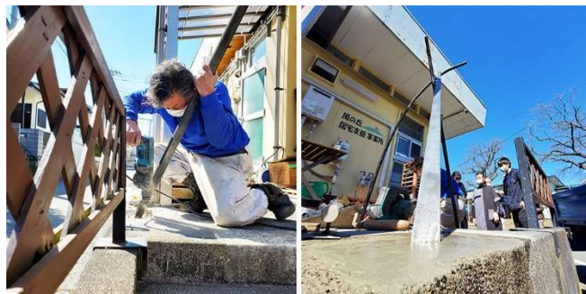
図25. ベースプレートをモルタルで埋め込み戻す
