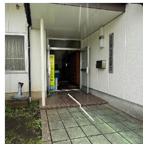
段差①: 玄関ポーチ 50mm
