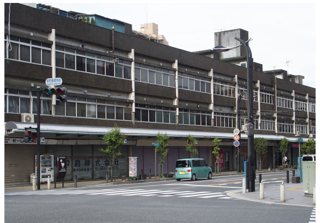
図 9 厚木中央通り防災建築街区 E 棟 (現状) (2、3 階の白い付柱が等間隔に並んでいないことがわかる)
