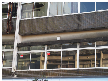
図14 E棟 壁面(現状)
