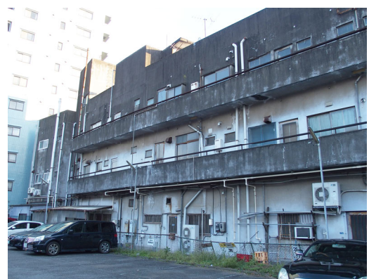
図 10 厚木中央通り防災建築街区 D 棟 裏側 (現状)
