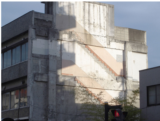
図16 中央通り防災建築街区F棟(現状) (切断された住棟の階段の断面が残る)
