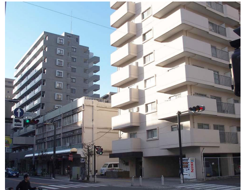
図17 中央通り防災建築街区B棟(現状)
