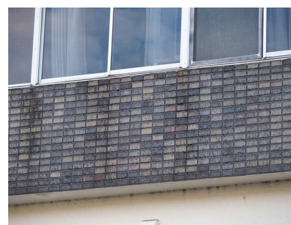
図15 F棟 壁面(現状)
