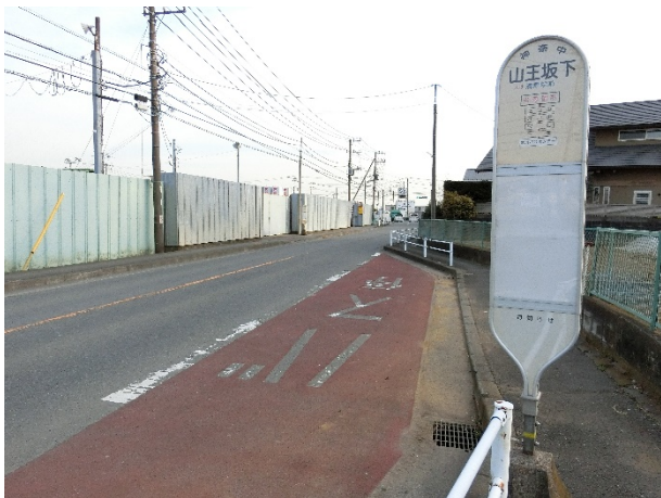
(i) 「全幅」の例：バス車体が収容できる停車帯
